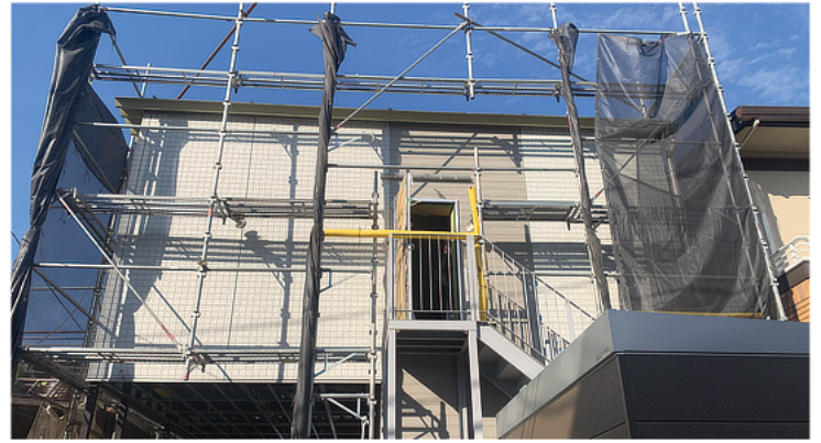
建設中の新自治会館の様子
